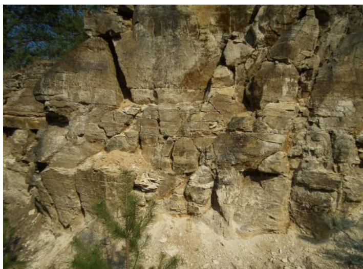
Ryc. 7. Spękania i uskoki w obrębie skał odsłaniających się w kamieniołomie w Żelebsku. Z prawej strony widoczny jest uskoki z brekcją tektoniczną i mączką tektoniczną ( gouge ). Fot. L. Jankowski.
