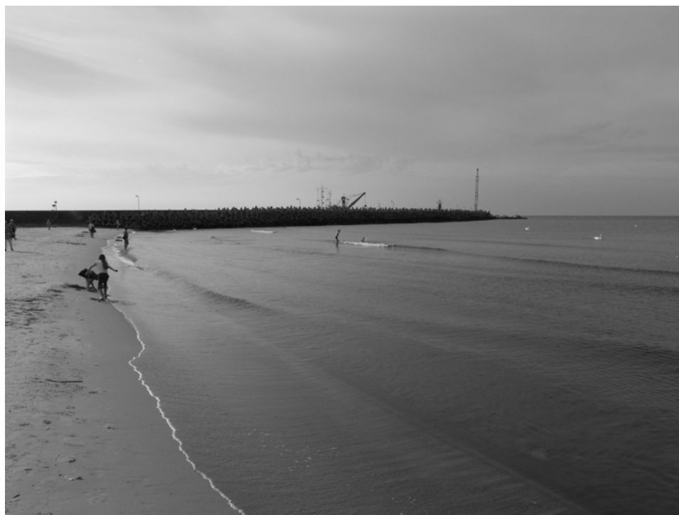
Fot. 1. Wschodni falochron portu kołobrzskiego w trakcie przebudowy
